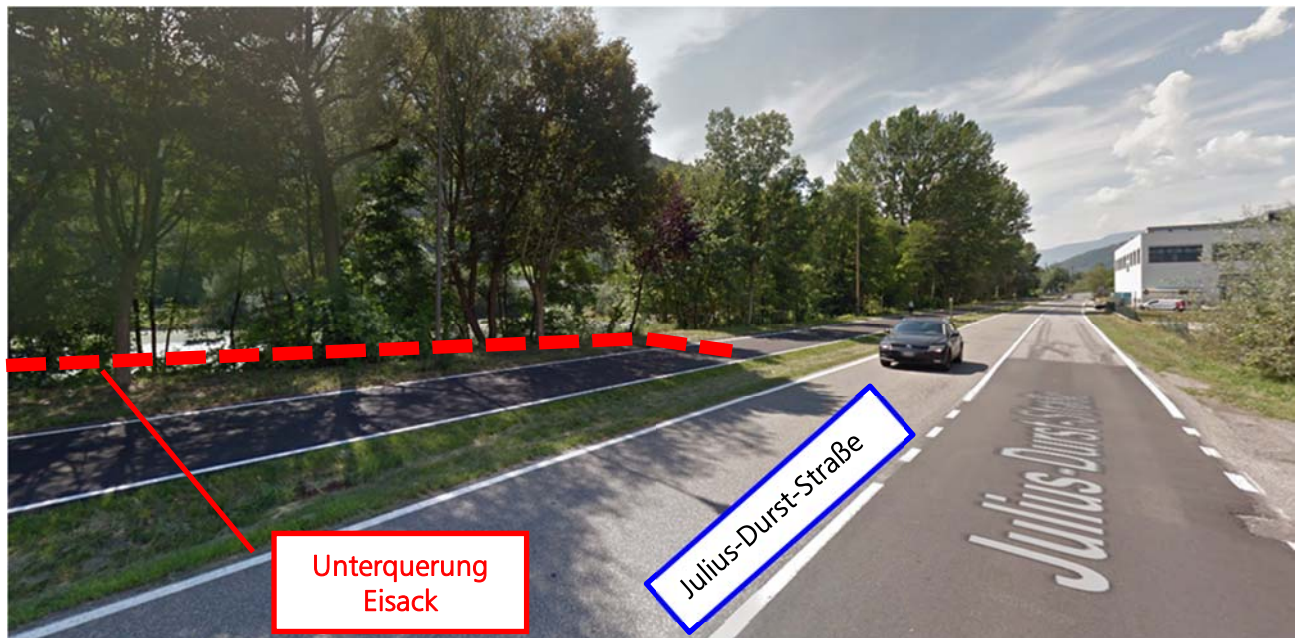
Foto 5: Position Eisackunterquerung – Blick in Richtung Süden - orographisch rechts Posizione sottoattraversamento del fiume Isarco - vista in direzione sud - destra idrografica
