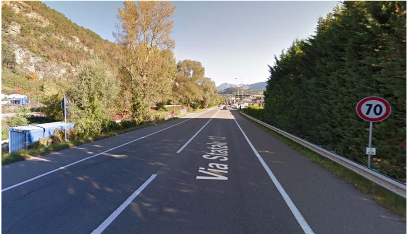
Foto 1: Parallelführung der Brenner Staatsstraße SS.12 Parallelismo con la strada statale del Brennero SS12
