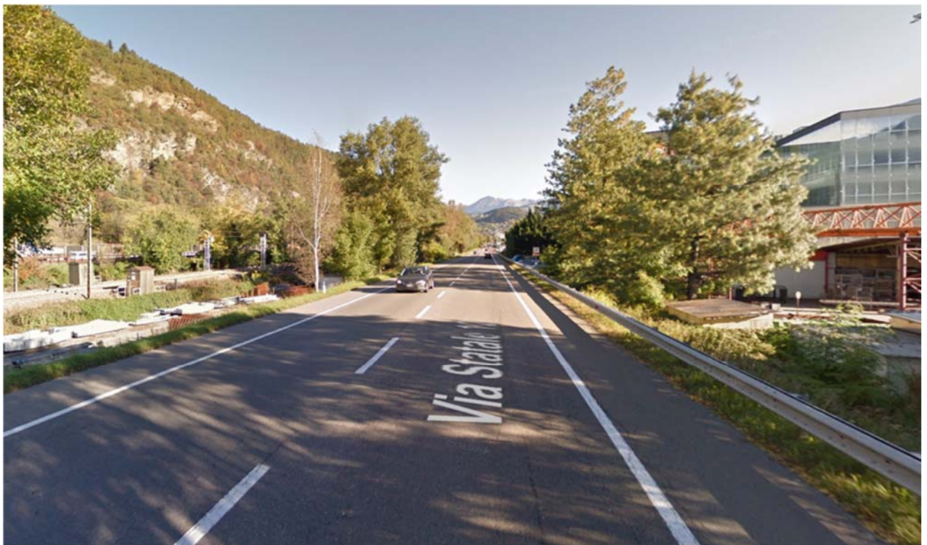
Foto 2: Parallelführung der Brenner Staatsstraße SS.12 Parallelismo con la strada statale del Brennero SS12
