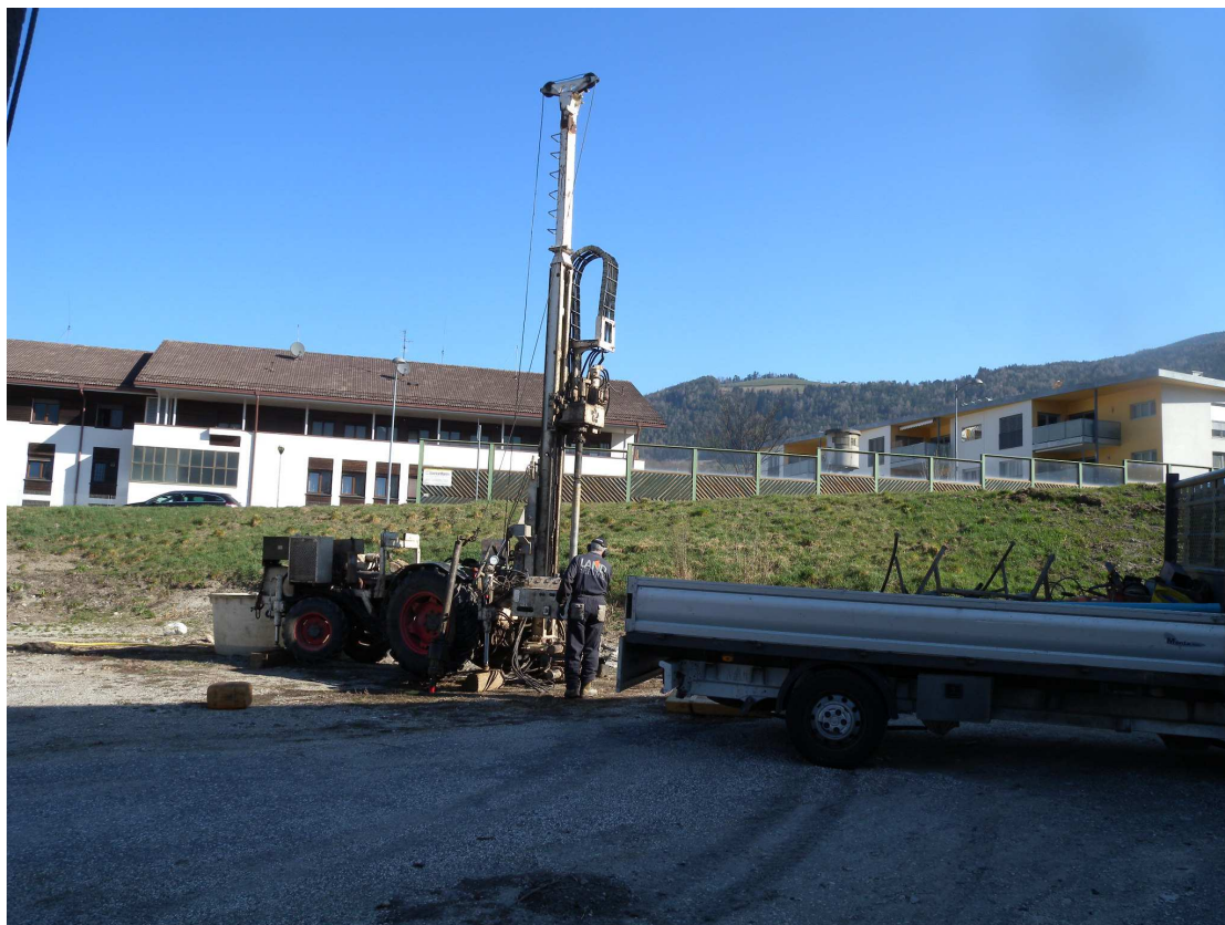
FOTO 3: esecuzione sondaggio S1.
