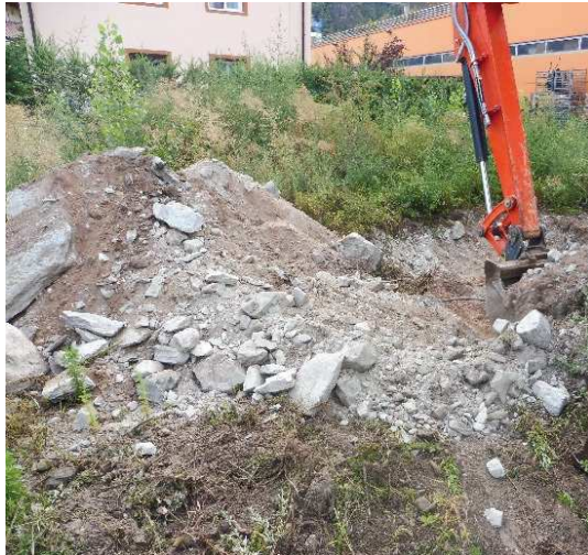
Abb. 7: Große Gesteinsblöcke in Sch1 Fig. 7: blocchi grossi in Sch1
