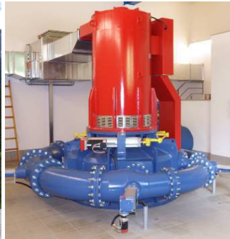
Turb. Pelton con generatore
